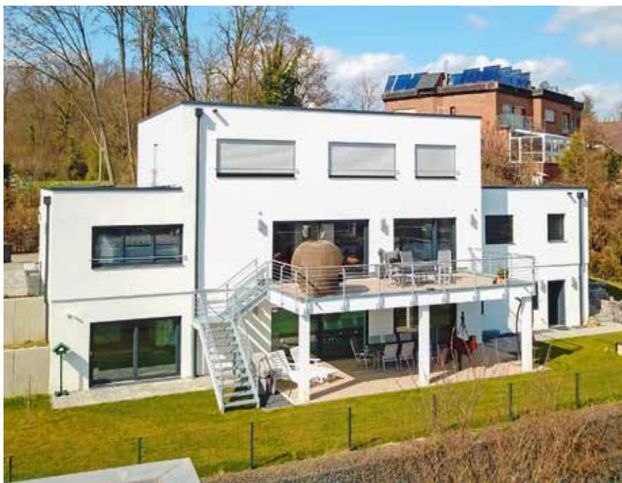
Baufamilien können Zeit und Aufwand sparen, wenn sie auf ein eingespieltes Team aus Kellerbaufirma und Fertighaushersteller setzen.
